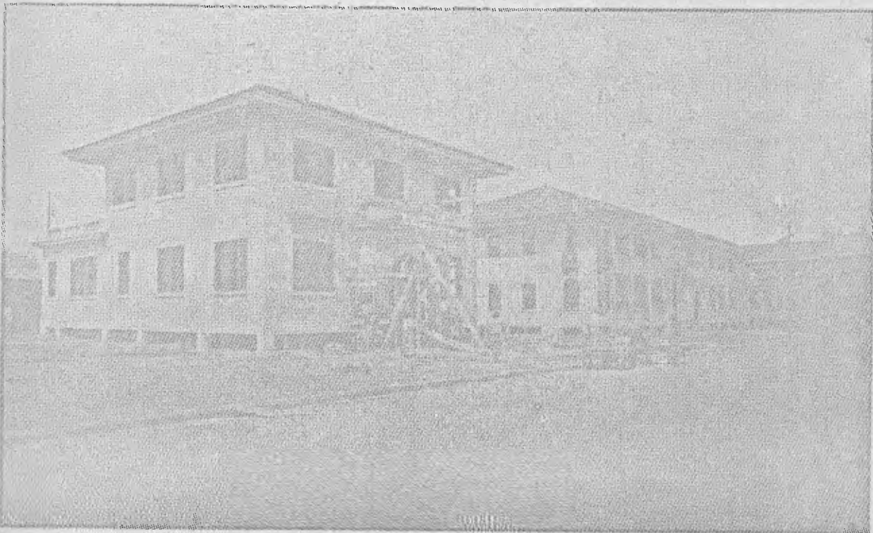
Vista del nuevo Hospital Santo Tomás en construcción.
